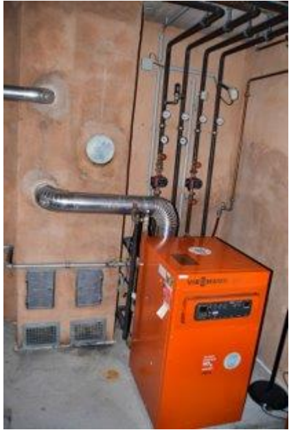
Abb.: Beispielhafte Abbildung eines Heizungskellers mit Gaskessel
