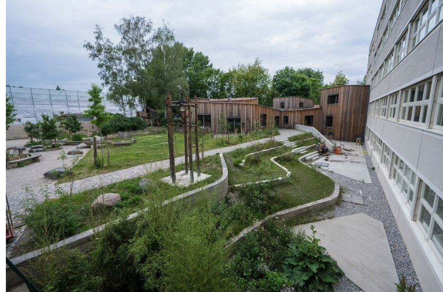
Abb. Freien Waldorfschule am Prenzlauer Berg (Berliner Regenwasseragentur)
